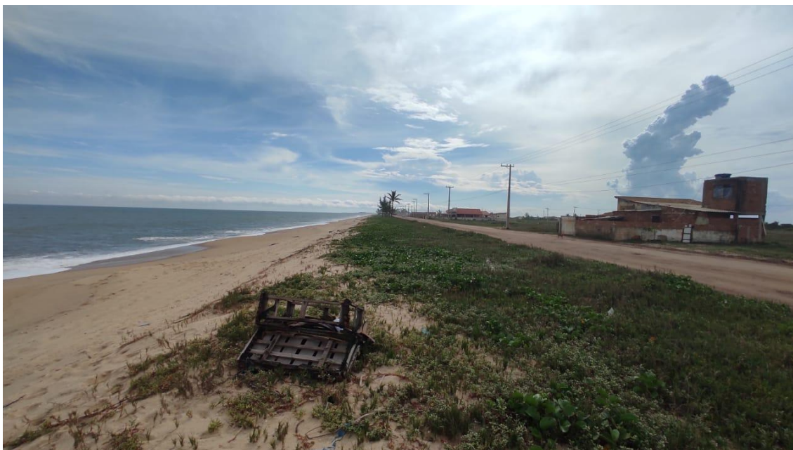
Figura 18 – Construções irregulares em trecho da Unidade III.
