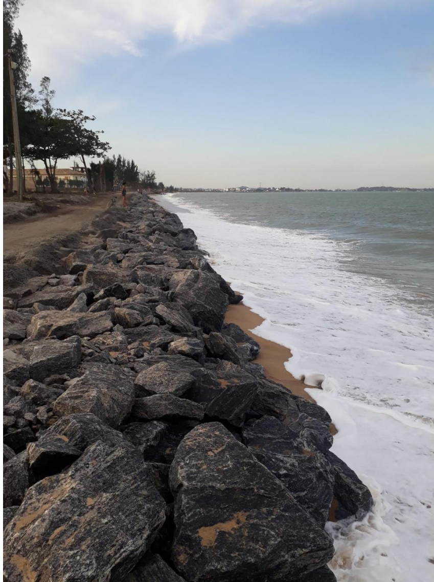
Figura 5- Exemplo de obra rígida de defesa do litoral paralela à linha de costa na orla marítima de Rio das Ostras-RJ.
